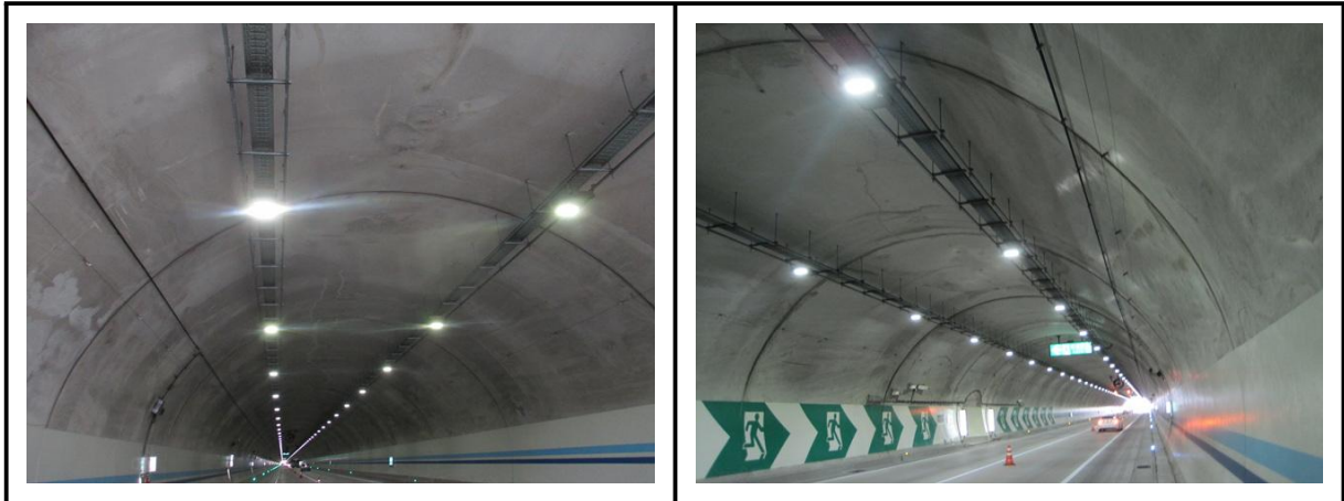
【사진 3.3.15】 라이닝 천단부 전경
