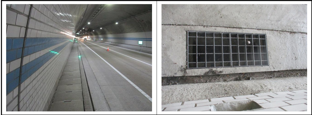
【사진 3.3.23】 공동구 및 배수시설 전경
