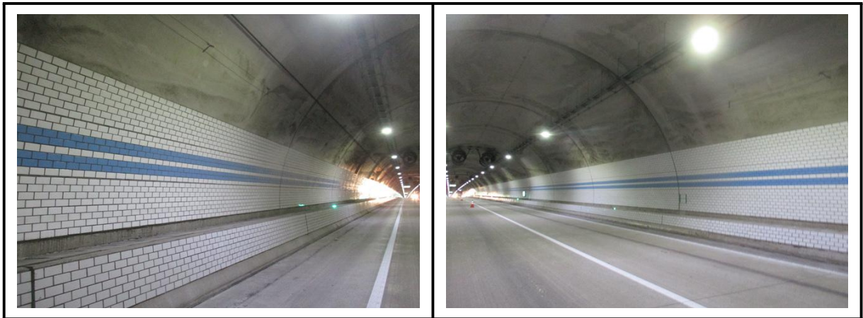
【사진 3.3.3】 라이닝 측벽부 전경
