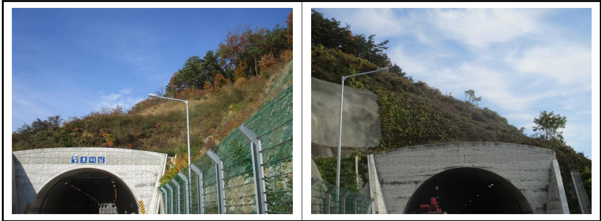
【사진 3.3.7】 사면 전경
