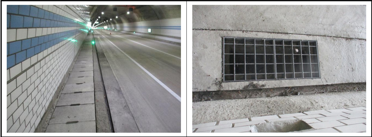
【사진 3.3.9】 공동구 및 배수시설 전경
