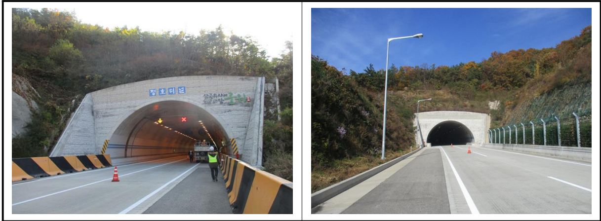
【사진 3.3.21】 사면 전경
