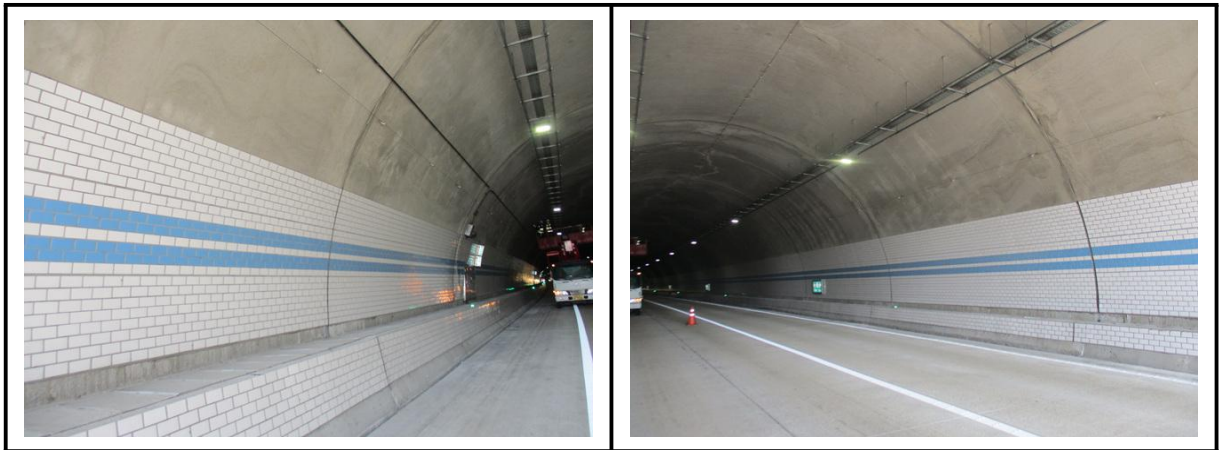
【사진 3.3.17】 라이닝 측벽부 전경
